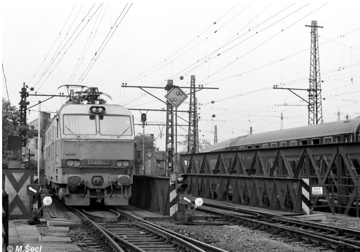
Obr.7 Lokomotiva ES 499.0019 na ocelových mostech přes dnešní Seifertovu ulici dne 23. 5. 1976. Foto Miroslav Šecl
